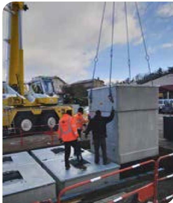
Container enterré pendu à la grue
