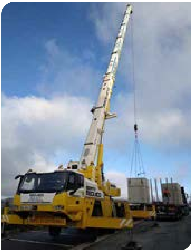
Container enterré pendu à la grue
