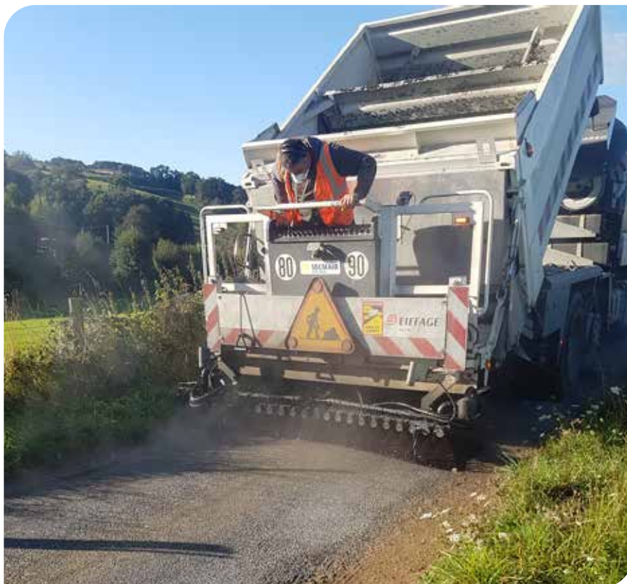
Application d'un bi-couche chemin du Moulin-Garin
