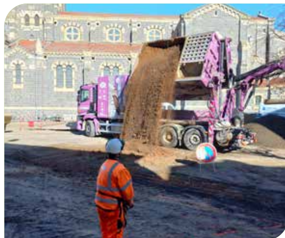
Travaux Place Neuve - Novembre 2024
