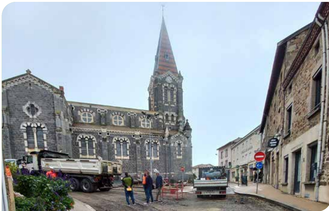
Travaux Place Neuve - Octobre 2024
