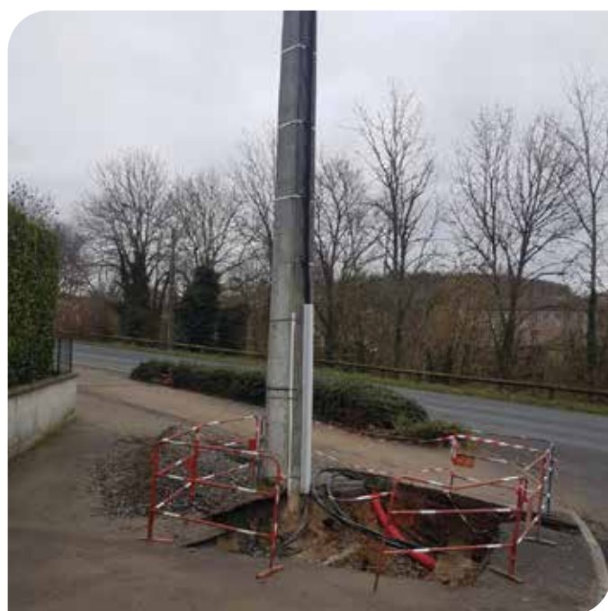
Dissimulation réseaux aériens avenue des Hauts du Lyonnais
