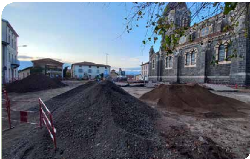
Travaux Place de l'église - Novembre 2024
