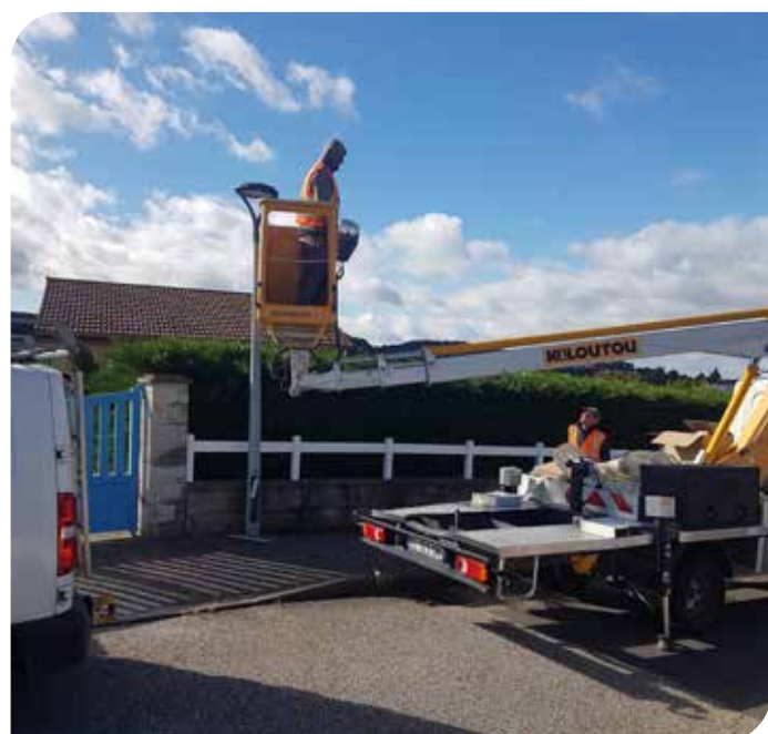
Passage en led de l'éclairage public
