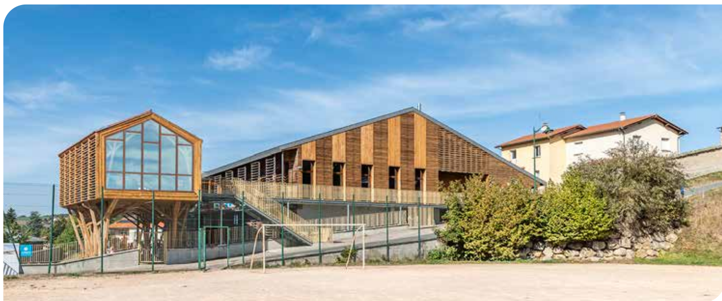
Extension du restaurant scolaire
