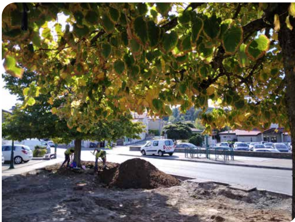
Travaux Place du Plomb
