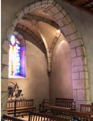
Arcs, nervures, encadrements en pierre de taille type granite
