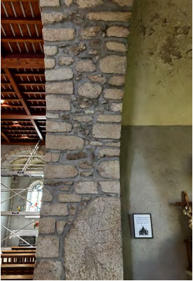
Chapelle Sainte Anne: sol en ciment avec faux appareillage de carreaux terre cuite, humidités, joints ciment, badigeon décollé
