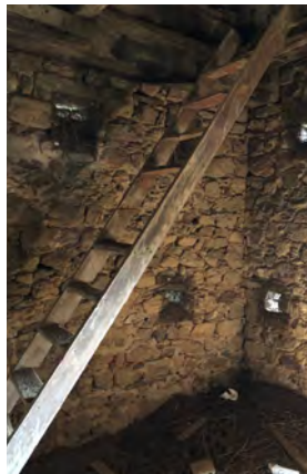
CLOCHER Intérieur: volatiles, échelle cassée, ancien passage depuis l'esc. hors oeuvre, assemblage des abat-sons altéré
