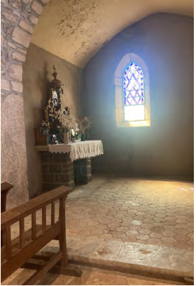
Chapelle Sainte Anne: sol en ciment avec faux appareillage de carreaux terre cuite, humidités, joints ciment, badigeon décollé
