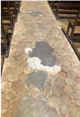
Éléments inesthétiques : protection du vitrail du chœur, peintures écaillées chapelle N-D, sols intérieurs altérés, projecteurs
