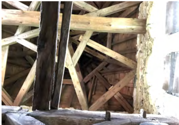
Charpente de la flèche avec ses enrayures et arases supérieures du clocher en pierres calcaires et calages en bon état
