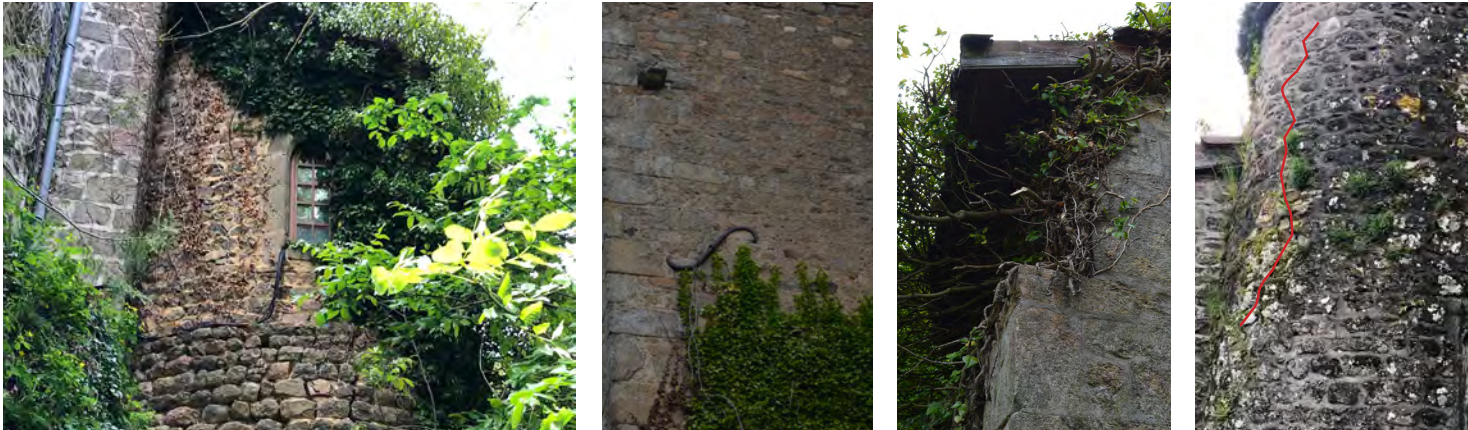
Abords : Mauvaises évacuations des eaux pluviales, rejailissement, développement mousse et végétation
