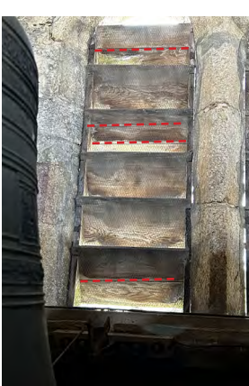
CLOCHER Intérieur: volatiles, échelle cassée, ancien passage depuis l'esc. hors oeuvre, assemblage des abat-sons altéré
