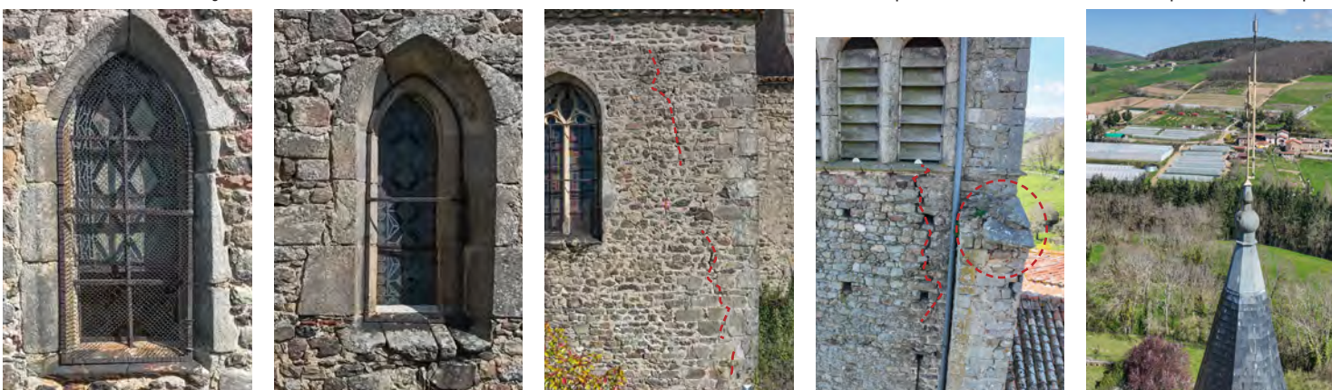
appuis cassés (Ste Anne + chœur faç Sud), fissure (Nd de piété+clocher Nord), tête de contrefort altérée, épi de faîtage et paratonnerre
