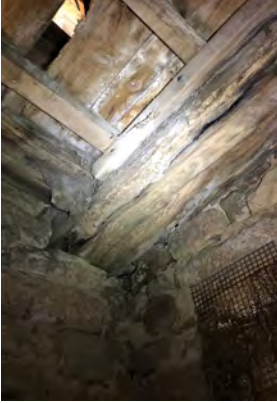
Désordres liés aux infiltrations d'eau: mur Ouest de Ste Anne, arrosage automatique en pied, desc. eau pluviale Ste Anne et clocher Nord
