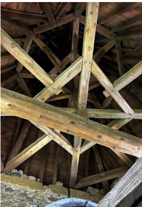
Charpente de la flèche avec ses enrayures et arases supérieures du clocher en pierres calcaires et calages en bon état
