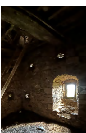
CLOCHER Intérieur: volatiles, échelle cassée, ancien passage depuis l'esc. hors oeuvre, assemblage des abat-sons altéré
