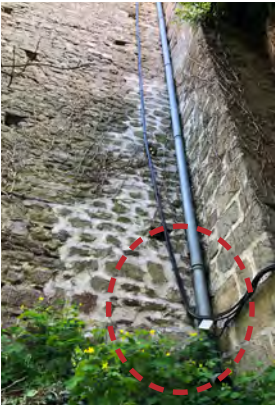
Désordres liés aux infiltrations d'eau: mur Ouest de Ste Anne, arrosage automatique en pied, desc. eau pluviale Ste Anne et clocher Nord
