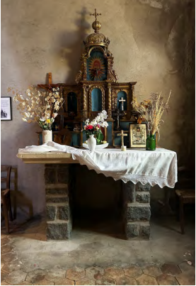
Chapelle Sainte Anne: sol en ciment avec faux appareillage de carreaux terre cuite, humidités, joints ciment, badigeon décollé
