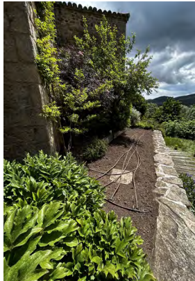
Désordres liés aux infiltrations d'eau: mur Ouest de Ste Anne, arrosage automatique en pied, desc. eau pluviale Ste Anne et clocher Nord
