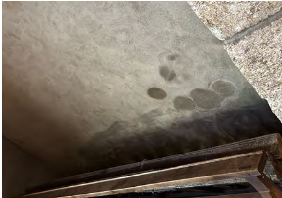
Désordres liés aux infiltrations d'eau: mur Ouest de Ste Anne, arrosage automatique en pied, desc. eau pluviale Ste Anne et clocher Nord
