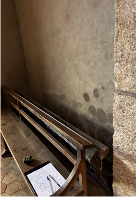
Chapelle Sainte Anne: sol en ciment avec faux appareillage de carreaux terre cuite, humidités, joints ciment, badigeon décollé
