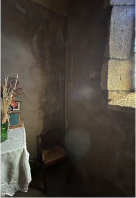
Chapelle Sainte Anne: sol en ciment avec faux appareillage de carreaux terre cuite, humidités, joints ciment, badigeon décollé
