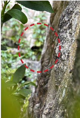
Désordres liés aux infiltrations d'eau: mur Ouest de Ste Anne, arrosage automatique en pied, desc. eau pluviale Ste Anne et clocher Nord
