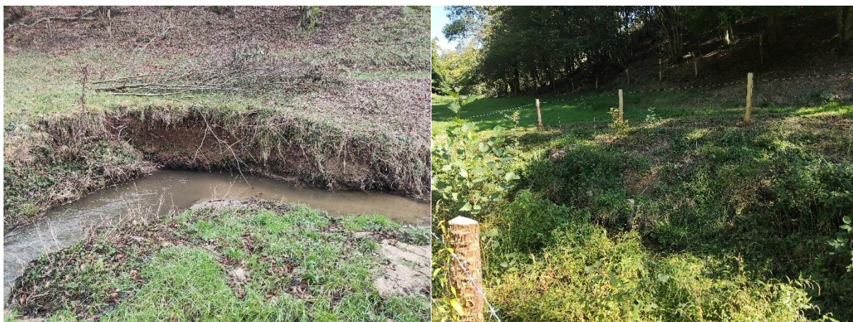
Gestion de l'érosion par des techniques de génie végétal sur le Coiset à Larajasse Travaux en cours et création d'un point d'abreuvement sur le Coiset
