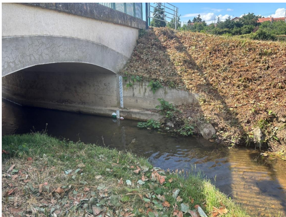
Echelle limnimétrique à Bellegarde-en-Forez
